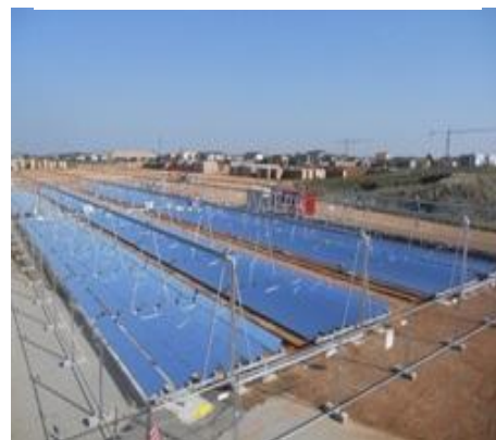
Fresnelspiegelveld van ongeveer 2500\text{ m}^2 voor de baksteenindustrie, Italië.
