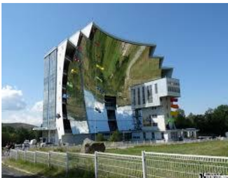
Zonneoven van 2000\text{ m}^2 in Odeillo, Zuid-Frankrijk. Maximum temperatuur 3500^{\circ}\text{C} .
