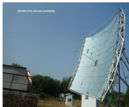
Zonaangedreven crematorium met Scheffler spiegel 50\text{ m}^2 in Gujarat, India. Temperatuur 700^{\circ}\text{C}
